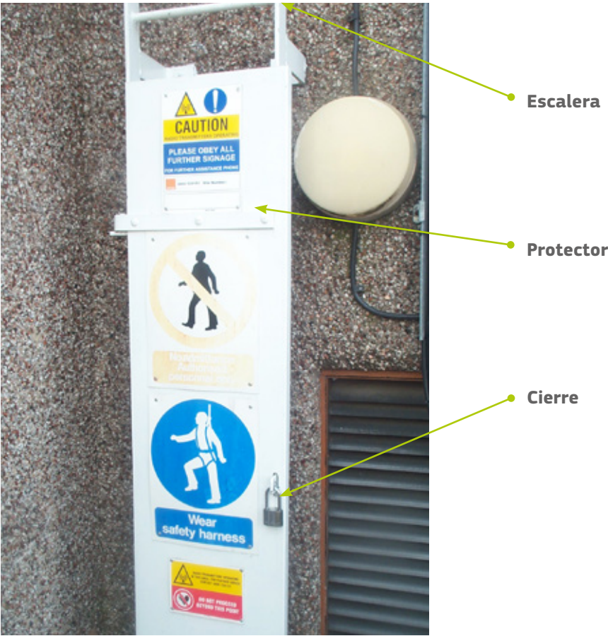
Figura 9.2. Uso de un protector de escalera para restringir el acceso a campos intensos en una azotea
