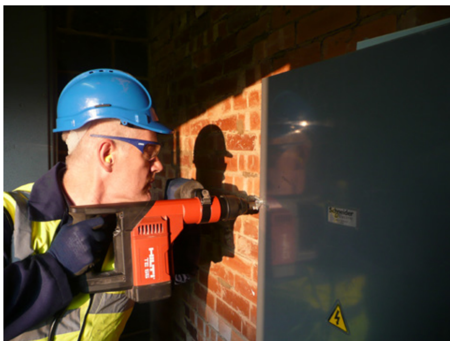
Figura 6.5. Trabajador que sostiene una herramienta eléctrica próxima al cuerpo. En esta situación, la exposición del cuerpo y de las extremidades será similar y se limitará con arreglo al cumplimiento de los NA superiores/inferiores.
