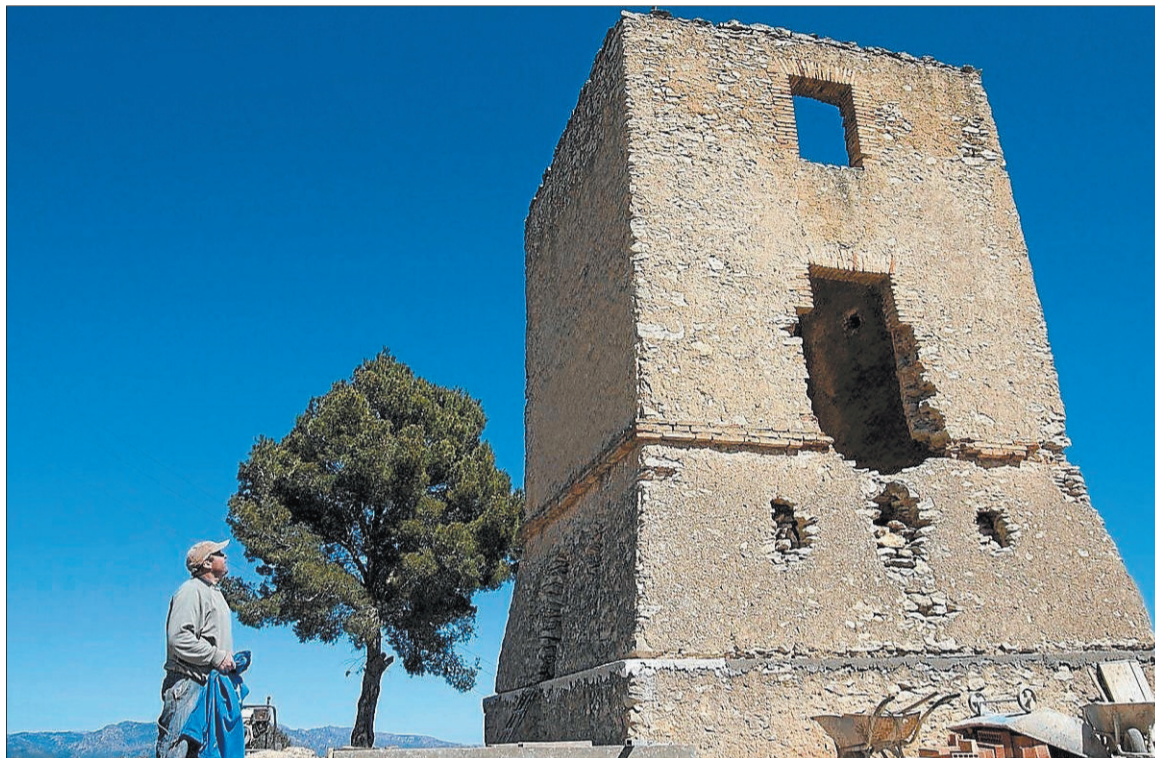
Imatge de la torre que aviat lluirà l'aspecte de com era fa dos segles. FOTO: JOAN REVILLAS
